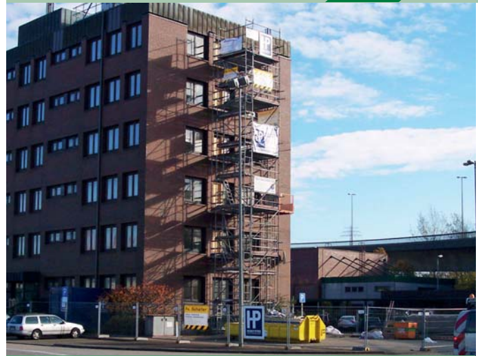
> Das Hochhaus während der Umbauphase.
